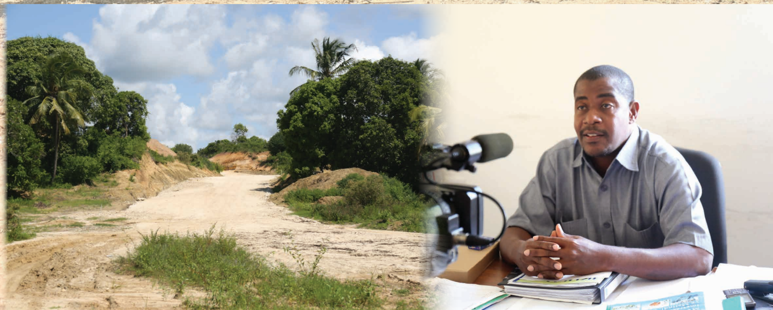
Sehemu ya Barabara mpya ya Ole - Kengeja inayoendelea kujengwa Kisiwani Pemba
