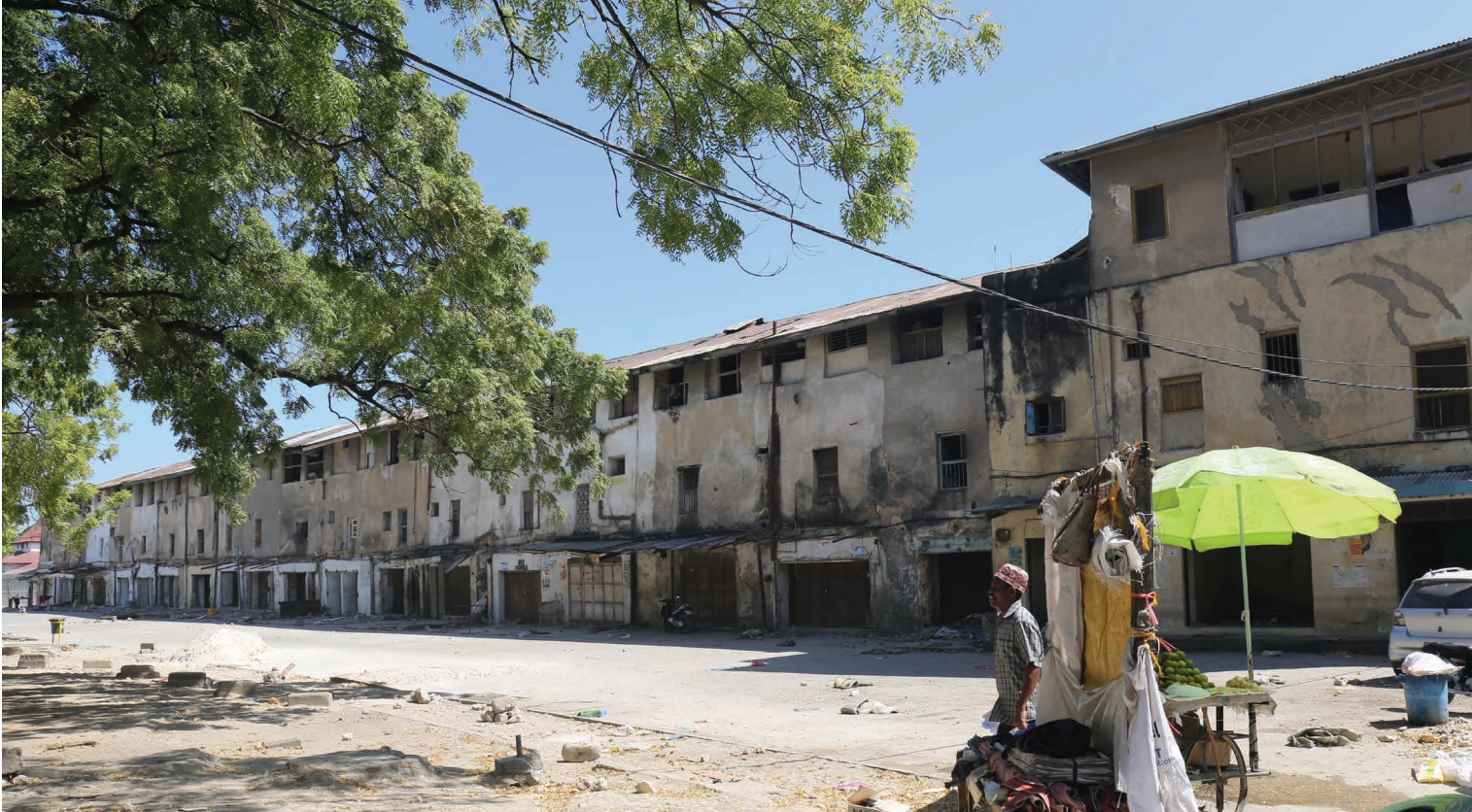
Jengo la Treni (Chawl Building) lililopo eneo la Darajani Mjini Unguja linalosubiri kubolewa na kupisha ujenzi wa jengo jengine jipya litalofanana na hili kwa ramani yake. Jengo hilo linatarajiwa kujengwa na Mfuko wa Hifadhi ya Jamii Zanzibar (ZSSF)
