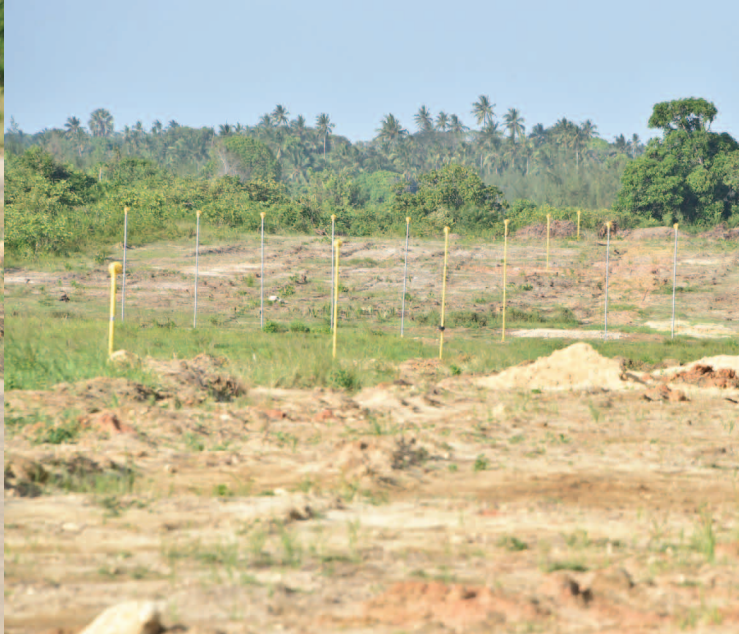
Baadhi ya Taa za kuongozea ndege zilizojengwa katika kiwanja cha ndege cha Karume Kisiwani Pemba
