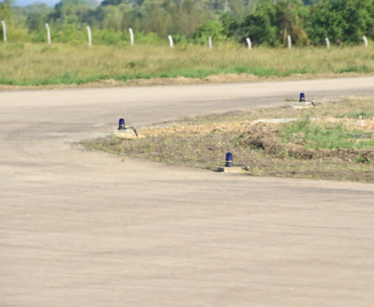
Baadhi ya Taa za kuongozea ndege zilizojengwa katika kiwanja cha ndege cha Karume Kisiwani Pemba
